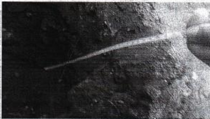
Кабельная линия на третьем участке вскрытия
