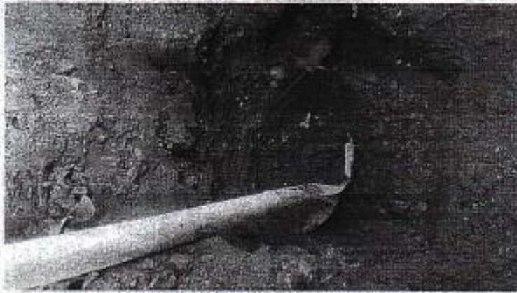
1-й участок вскрытия траншеи
