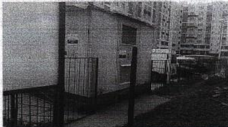
Фото №4 РУ-10кВ ТП110 АО «Янтарьэнерго»
