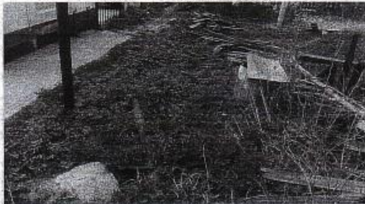
Фото № Кабельная линия около РУ-10кВ
