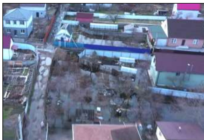
Фото 26. Затопленные участки между ул. Весенней и ул. Солнечной
