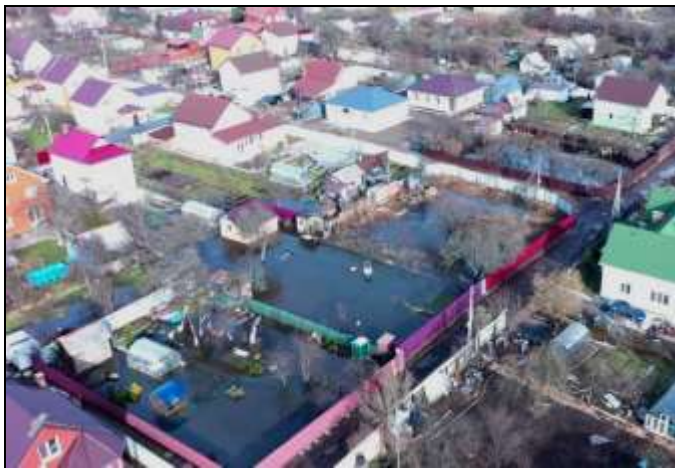
Фото 11. Затопленные участки между ул. Радужной и ул. Весенней
