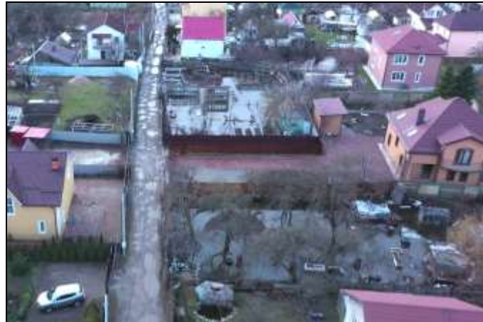
Фото 24. Затопленные участки между ул. Весенней и ул. Солнечной
