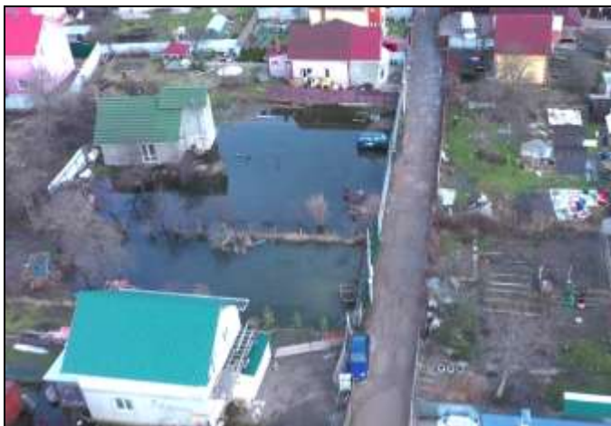
Фото 27. Затопленные участки между ул. Радужной и ул. Весенней
