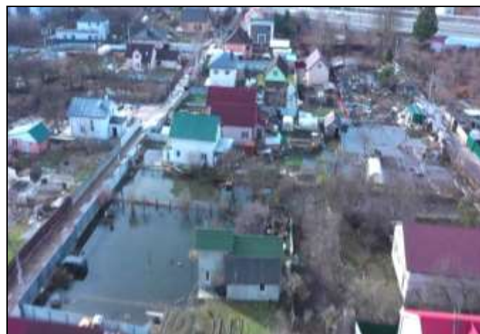
Фото 16. Затопленные участки между ул. Радужной и ул. Весенней
